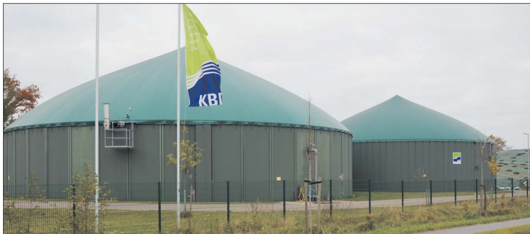
Die Biogasanlage an der Alvesloher Straße ist der einzige KBE-Betrieb, der Gewinne erwirtschaftet. Fotos ach
